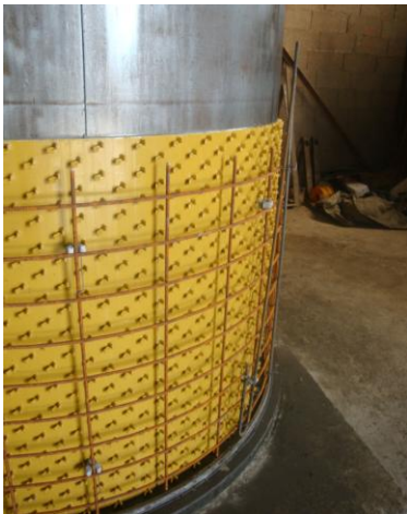
Mise en œuvre
