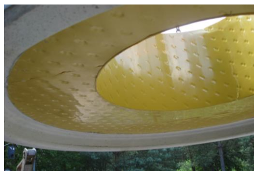
Revêtement intérieur de la dalle avec du CORPROTECT (PP) de chez PREDL
