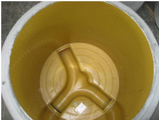
Revêtement intérieur du regard de visite avec du CORPROTECT (PP) de chez PREDL
