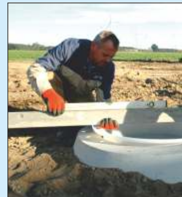
Teleskop z regulacją wysokości umożliwia dostosowanie do nachylenia ulicy w zakresie do 5%
