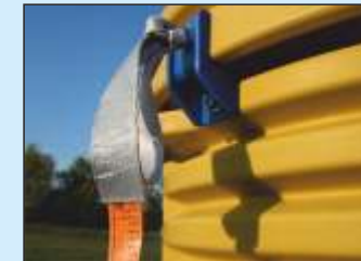
Śruby oczkowe w osadzonych tulejach gwintowanych do mocowania zawiesi jednorazowych jako pomocy montażowej
