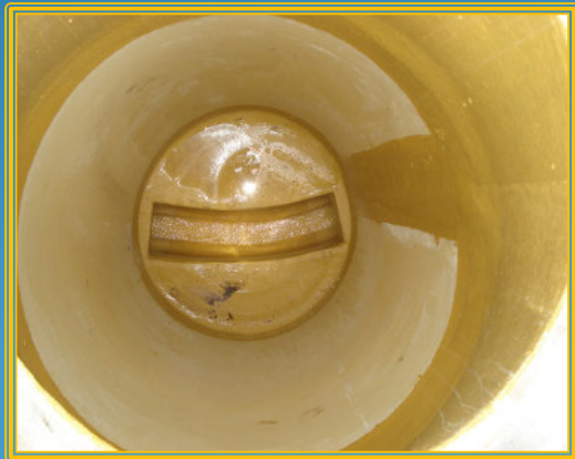
Sanierung mit GFK-Sanierungsschachtboden + GFK-Rohrliner 3 mm
