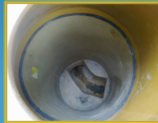
System Schacht in Schacht mit GFK-Sanierungsschachtboden + GFK-Rohr
