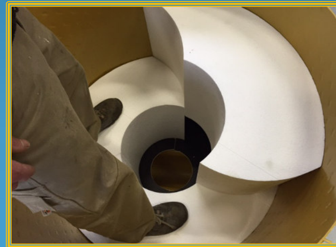
Sanierung mit CORPROTECT in offener Bauweise
