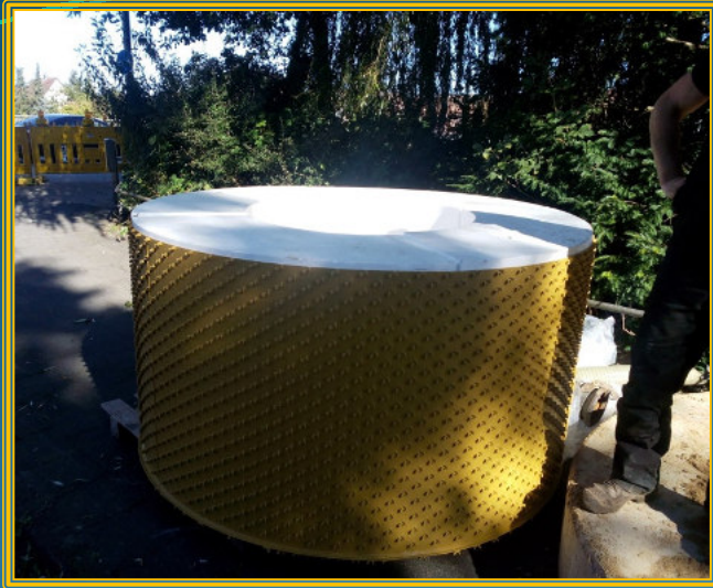
Sanierung mit CORPROTECT in offener Bauweise
