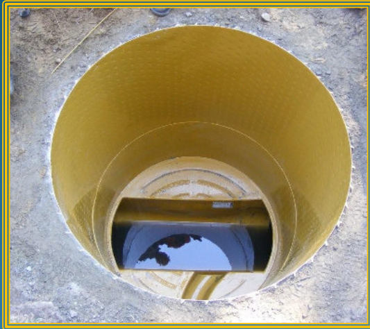
Sanierung mit CORPROTECT-Lining in PP (offen oder durch den Konus)
