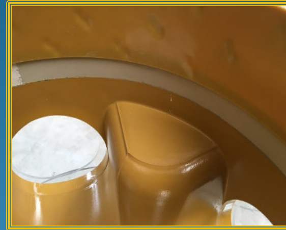
Sanierung mit GFK-Sanierungsschachtboden + CORPROTECT-Liner
