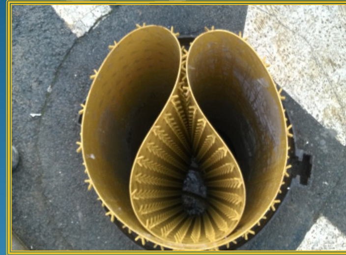
Sanierung mit CORPROTECT in offener Bauweise
