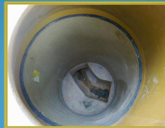
Système „regard dans regard“ cunette de réhabilitation en PRV + Tuyau en PRV
