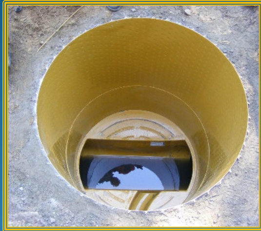
Réhabilitation avec revêtement CORPROTECT en PP (ouvert ou par trou d'homme)
