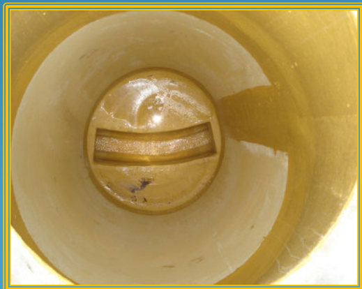
Réhabilitation avec cunette en PRV + Revêtement liner en PRV 3 mm
