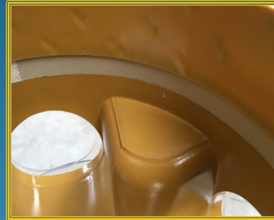
Réhabilitation avec cunette en PRV + Revêtement CORPROTECT en PP
