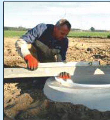
Výškově nastavitelný teleskop se může přizpůsobit spádu vozovky max. 5%.
