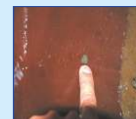
Tvorba bublin a odlupování kvůli zbytkové vlhkosti v betonu, nedostatečné síle vrstvy a účinkům vztlakovosti spodní vody.
