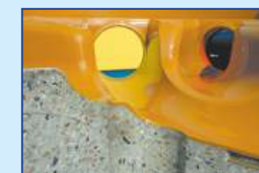
Konečné spojení s betonem, trvalá nášlapná vrstva o síle min. 4 mm v oblasti dna.
