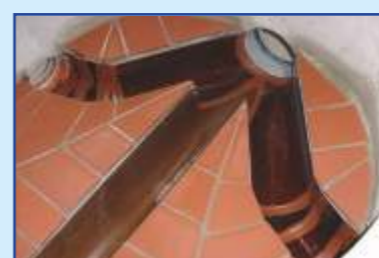
spáry a ostré hrany žlabu – nevýhodné pro provoz kanalizace
