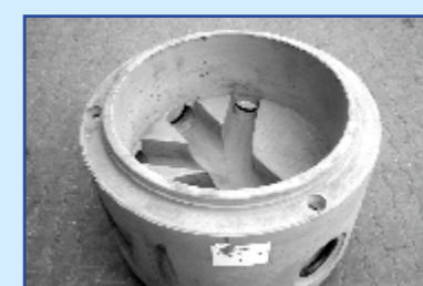
spáry a ostré hrany žlabu – nevýhodné pro provoz kanalizace
