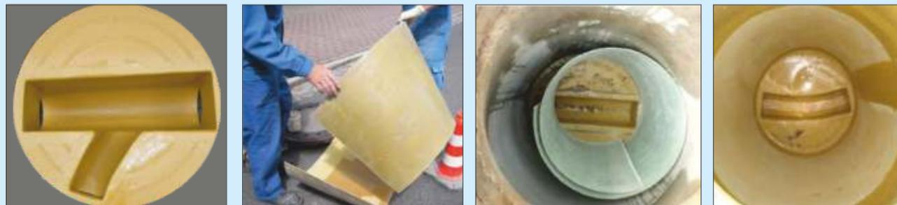
Schachtsanierung mit PREDL-GFK-Bauteilen: GFK-Schachtboden und flexibler GFK-Rohrliner für Schachtringe sowie GFK-Konusauskleidung (ebenfalls „durch den Konus“ möglich)
