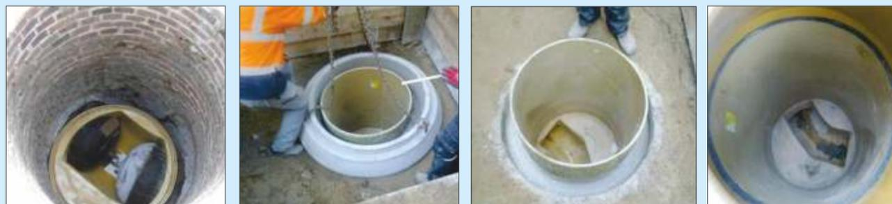
GFK-Schachtboden und GFK-Rohr für Schachtringe sowie GFK-Konusauskleidung (Sanierung „Schacht in Schacht“, hierbei muss der Konus des Altschachtes abgenommen werden)
