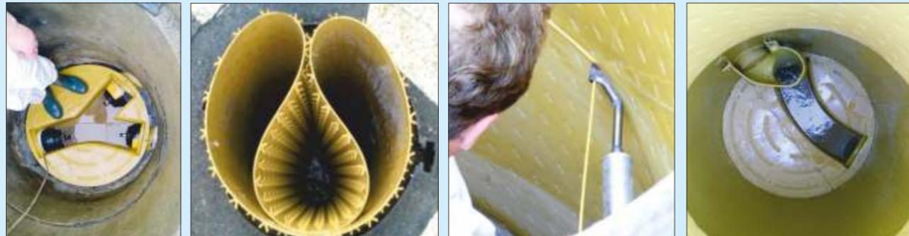
Die Sanierung mit CORPROTECT®-lining kann sowohl in offener Bauweise als auch ohne Abnehmen des Schachtkonus durchgeführt werden
