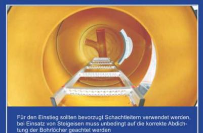
Für den Einstieg sollten bevorzugt Schachtleitern verwendet werden, bei Einsatz von Steigeisen muss unbedingt auf die korrekte Abdichtung der Bohrlocher geachtet werden
