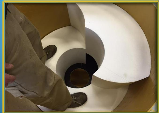
Abstützung der CORPROTECT-Auskleidung mit EPS
