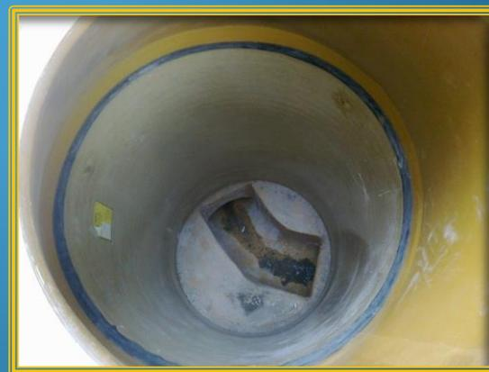
System Schacht in Schacht mit GFK-Sanierungsschachtboden + GFK-Rohr
