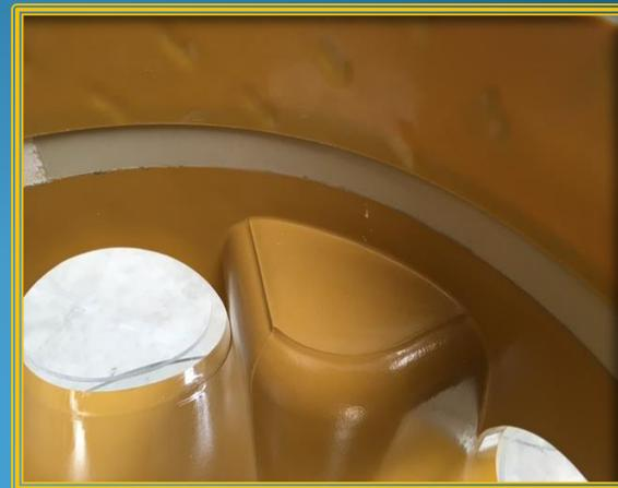
Sanierung mit GFK-Sanierungsschachtboden + CORPROTECT-Liner
