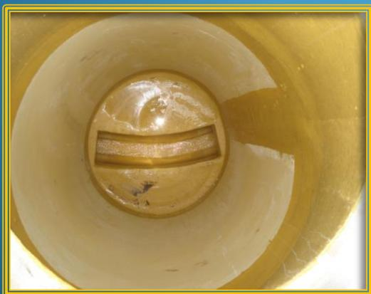
Sanierung mit GFK-Sanierungsschachtboden + GFK-Rohrliner 3 mm
