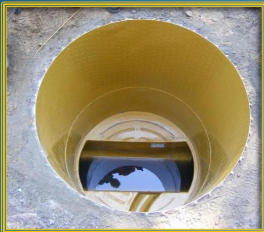
Sanierung mit CORPROTECT-Lining in PP (offen oder durch den Konus)
